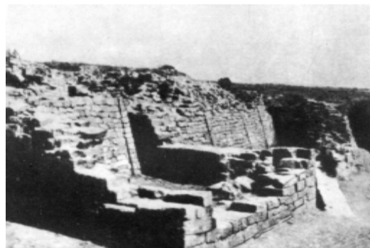
11. Крепостная стена Трои.
