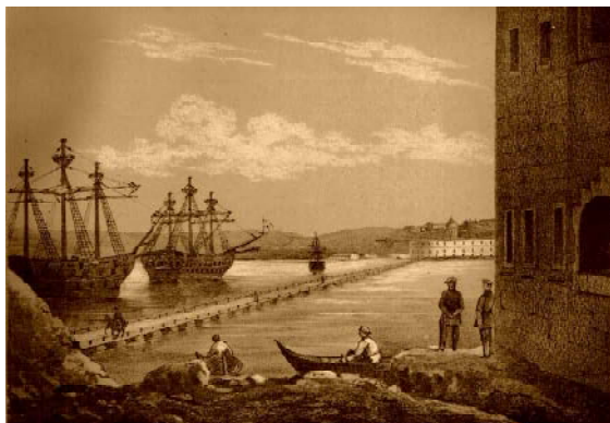
25. Мост с Южной стороны на Северную. Протянулся от Николаевских казарм до Михайловской батареи на 916 метров. Состоял из шести участков по 14 деревянных пловцов в каждом.
